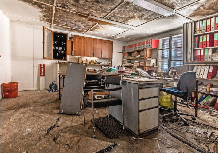
Später abgerissen: Personalhaus Brunner in Honau.
