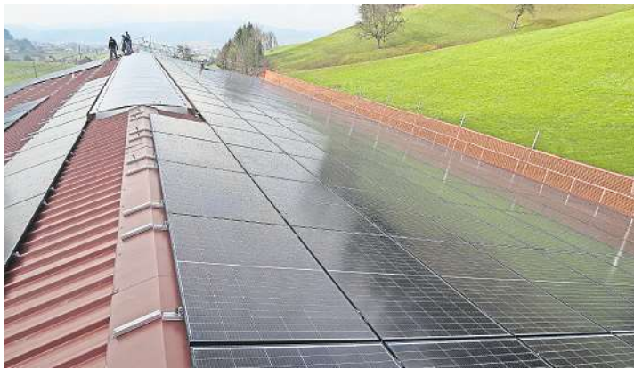
Beeindruckende Masse: Auf diesem Dach mit 1000 Quadratmeter Fläche wird die erste Hälfte der Solarpanels installiert.
