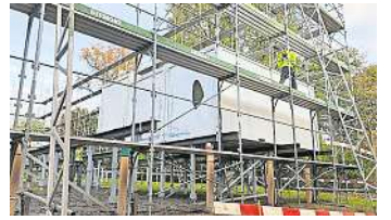
Montage eines Containers für die Siedlung. Bild: zvg
